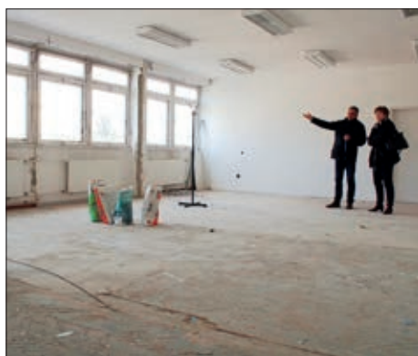
Obnova školske zgrade u Sambotelu
