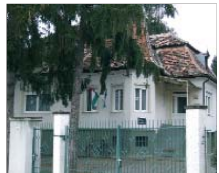
Prelipa zgrada čuvarnice
